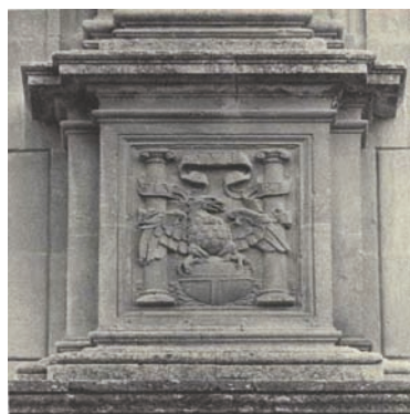
Columnas del Palacio de Carlos I
